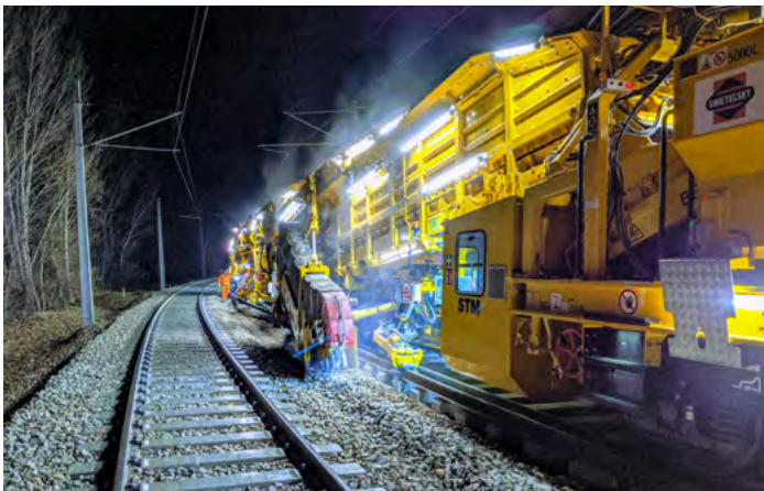
Maschinelle Gleisneulage auf der WLB-Strecke, Traiskirchen-Baden, Österreich
