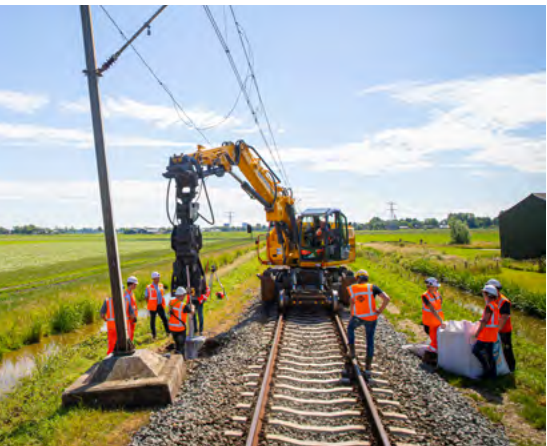
Erneuerte Fundamente, Heerhugowaard-Enkhuizen, Niederlande
