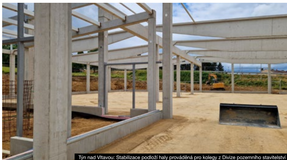
Týn nad Vltavou: Stabilizace podloží haly prováděná pro kolegy z Divize pozemního stavitelství
