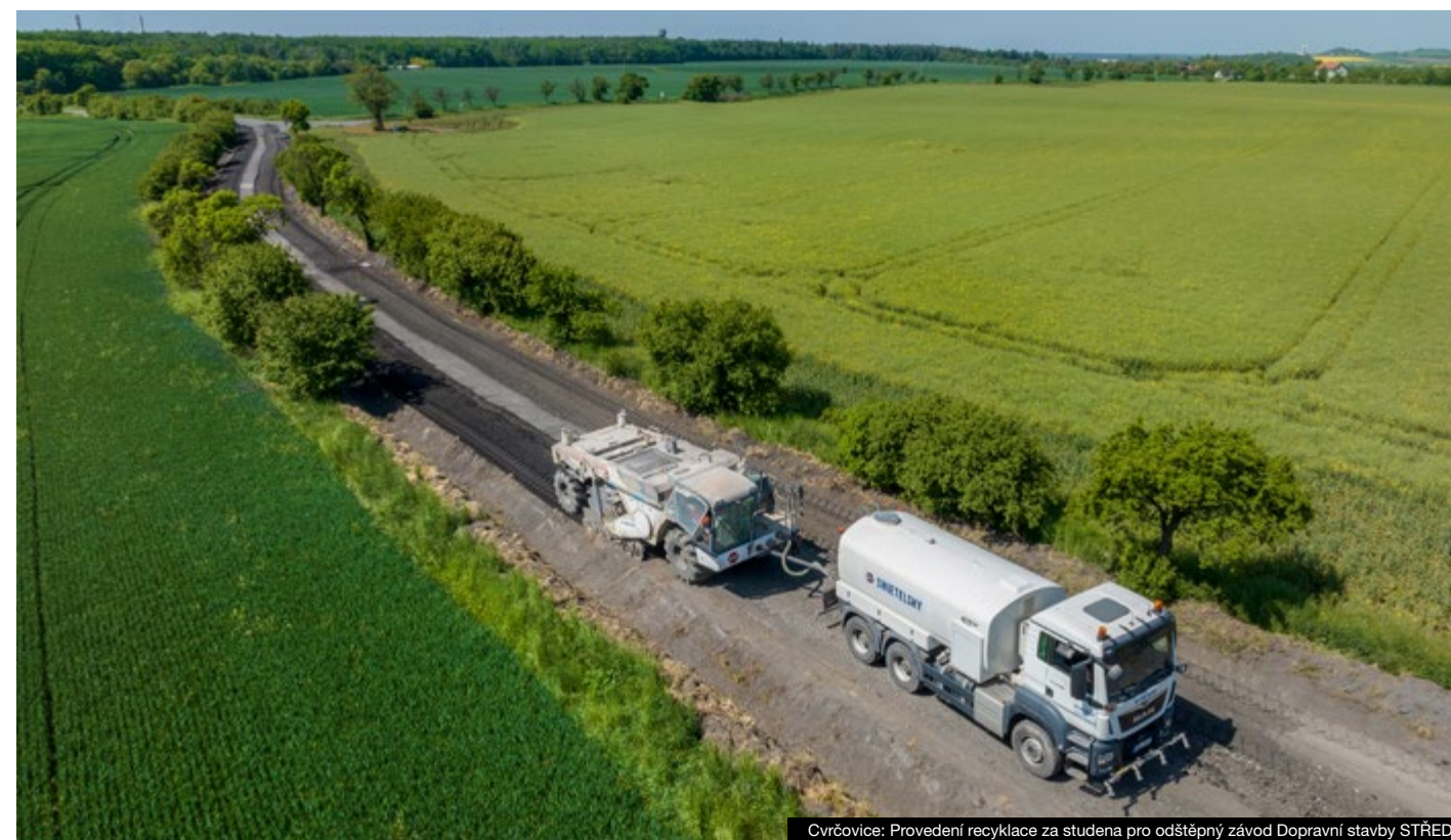
Cvrcovice: Provedení recyklace za studena pro odštěpný závod Dopravní stavby STŘED
